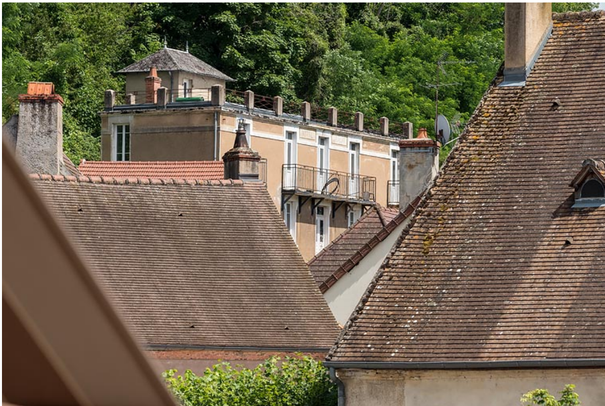
Façade de l'extension ("annexe").
