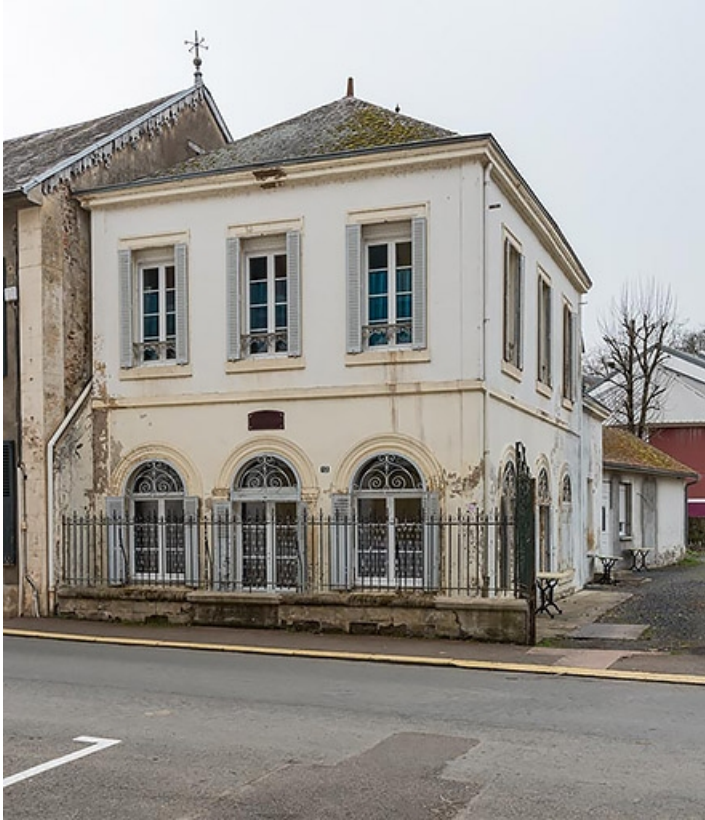
Façades sur l'avenue de la Libération.
