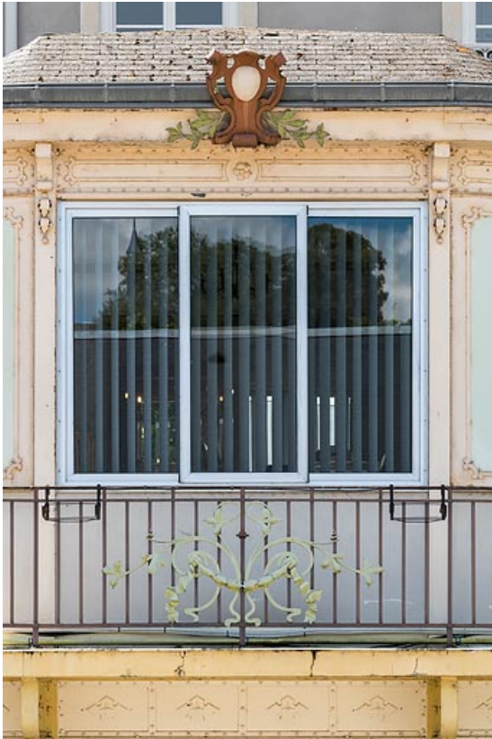
Aile ouest, salle à manger, détail.
