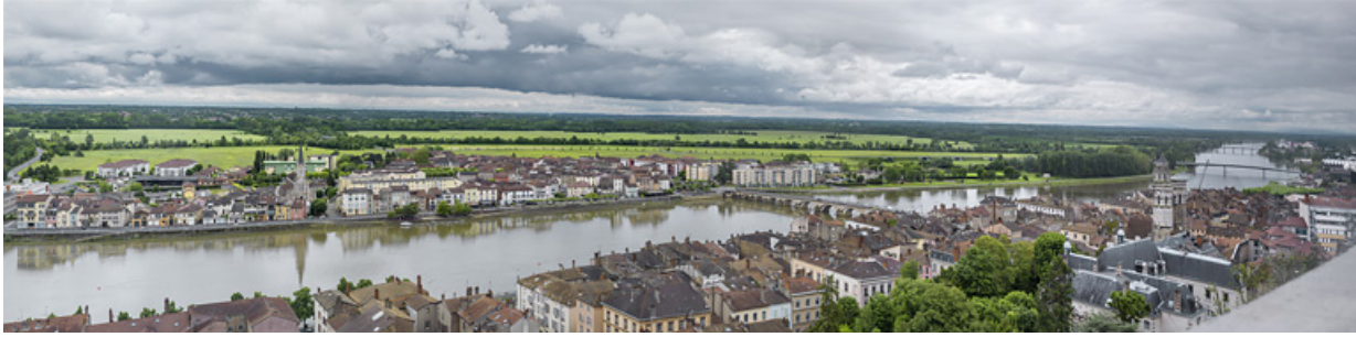
Vue panoramique de la traversée de Mâcon.
