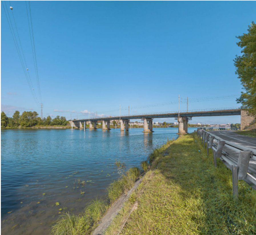
Le pont vu d'aval, rive gauche.
