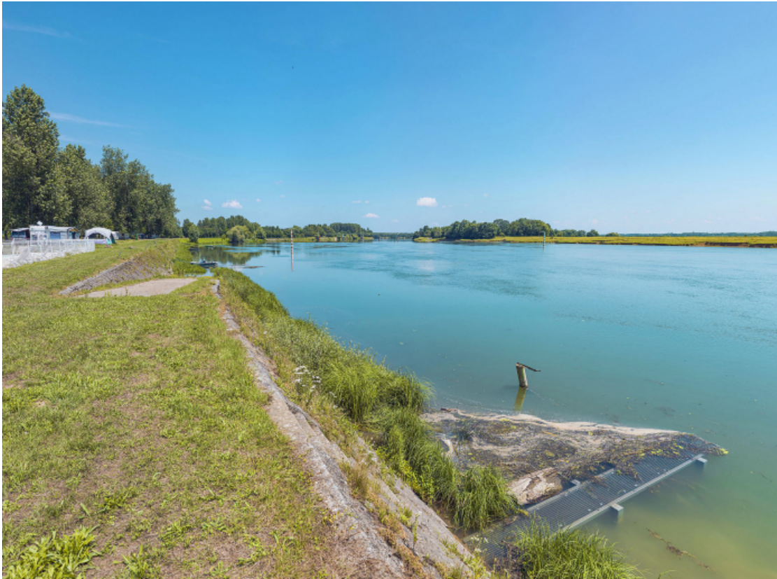
Rampe, perrés et escalier du port d'Uchizy.
