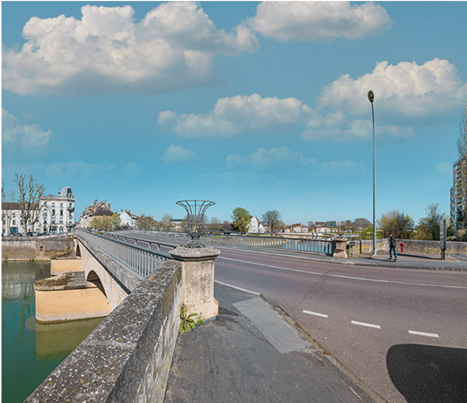
Vue d'ensemble du pont depuis la chaussée.
