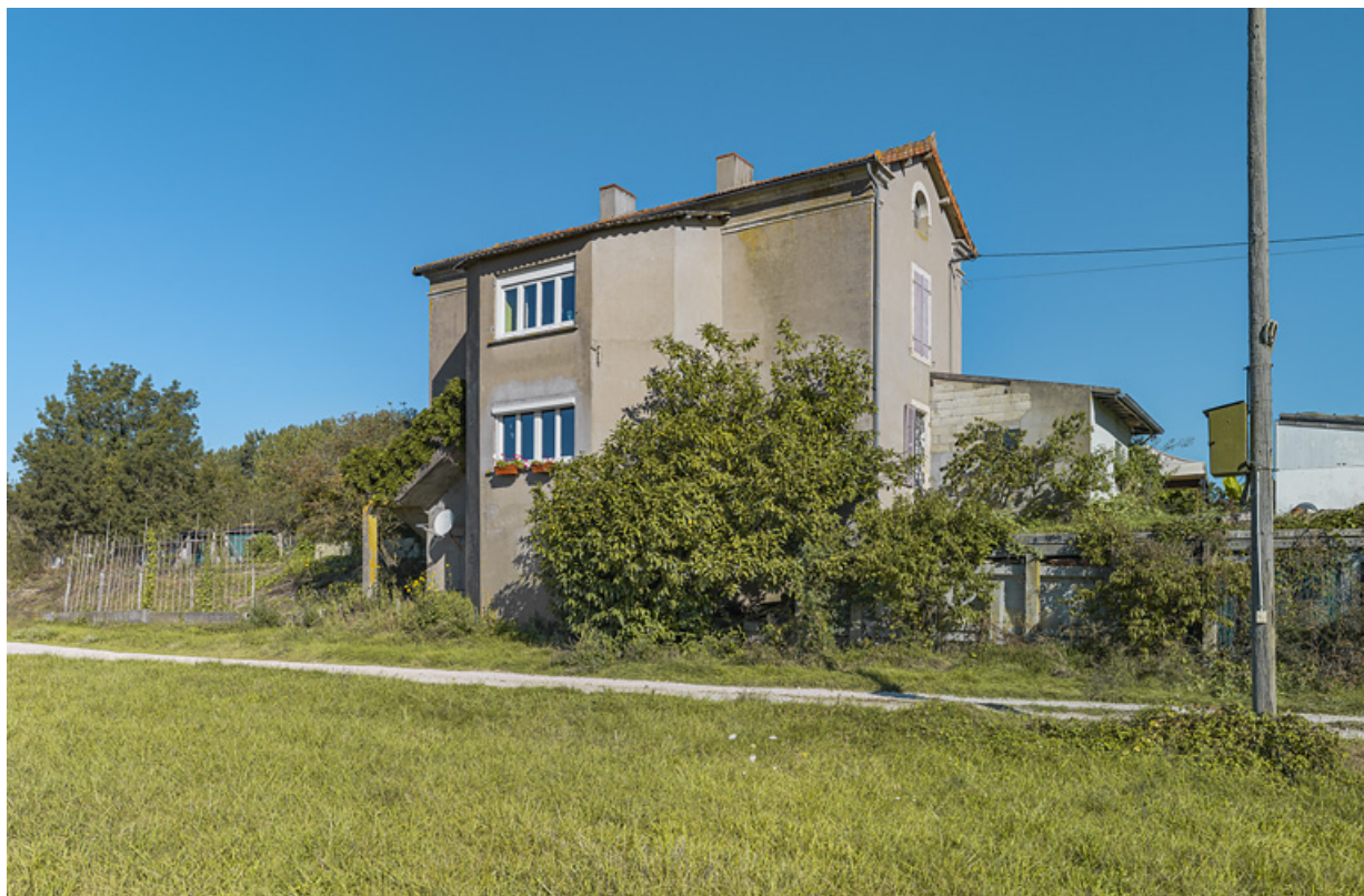
Façade arrière avec l'ajout d'un avant-corps central.
