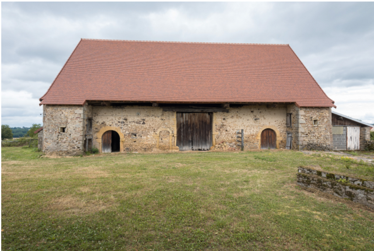
Vue frontale de la grange
