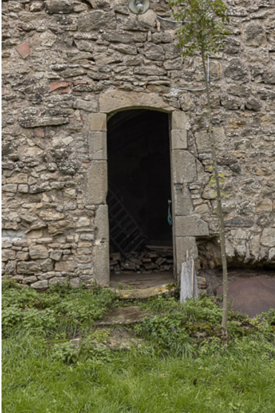
Porte d'accès au rez-de-chaussée de la tour
