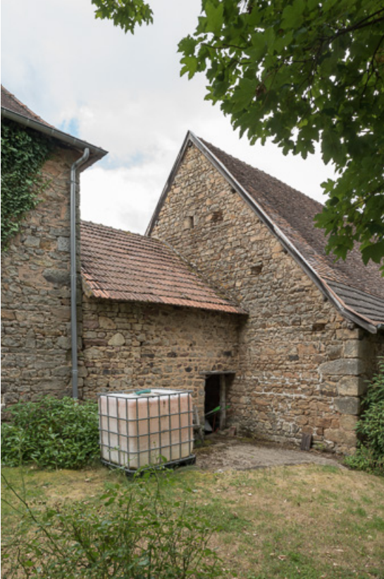
Façade postérieure de cette même remise.
