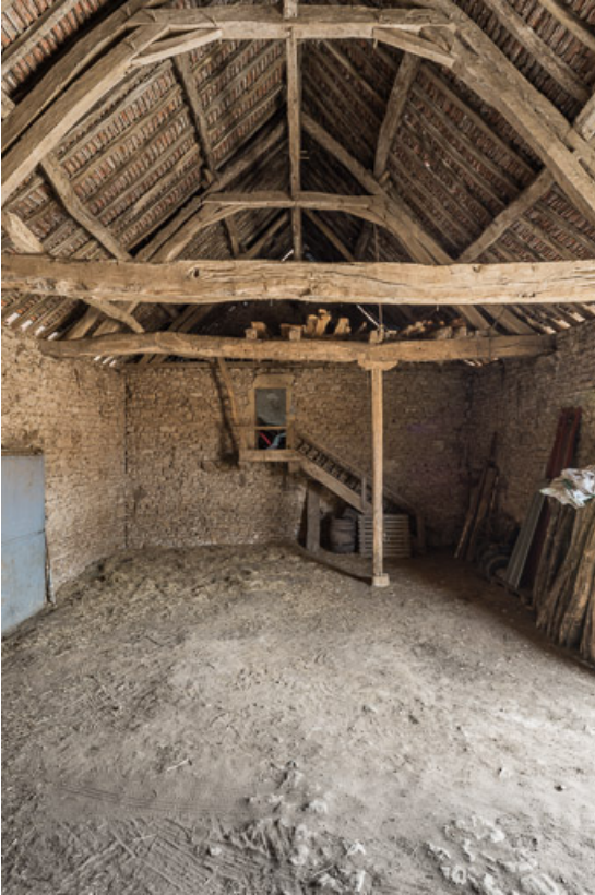
Vue intérieure du cuvage
