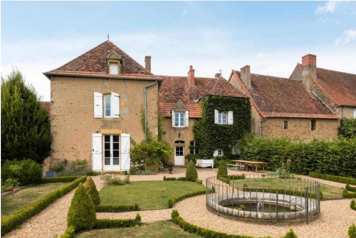
Façade postérieure de la maison
