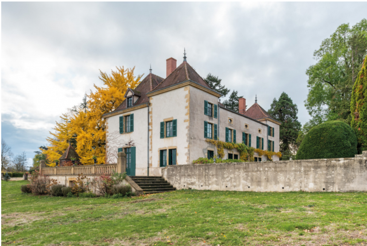
Château : vue de l'est
