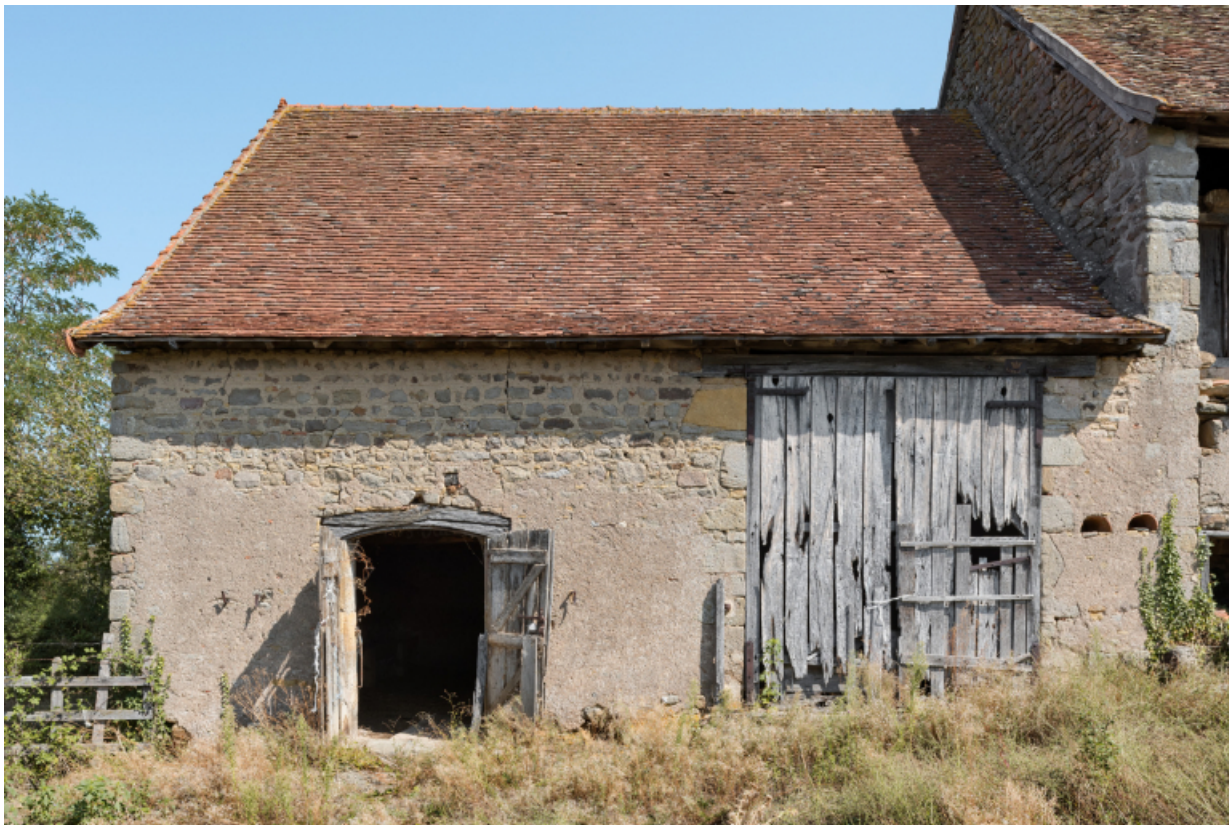
Vue de face des parties agricoles.
