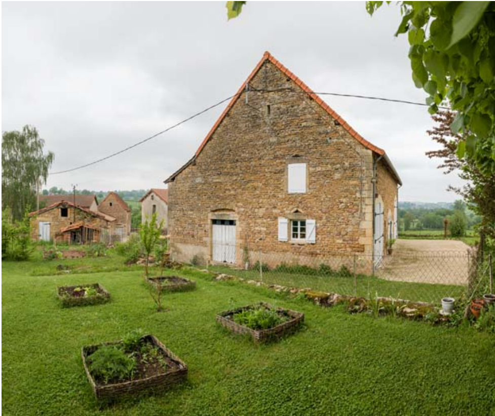
Pignon sud de l'étable.
