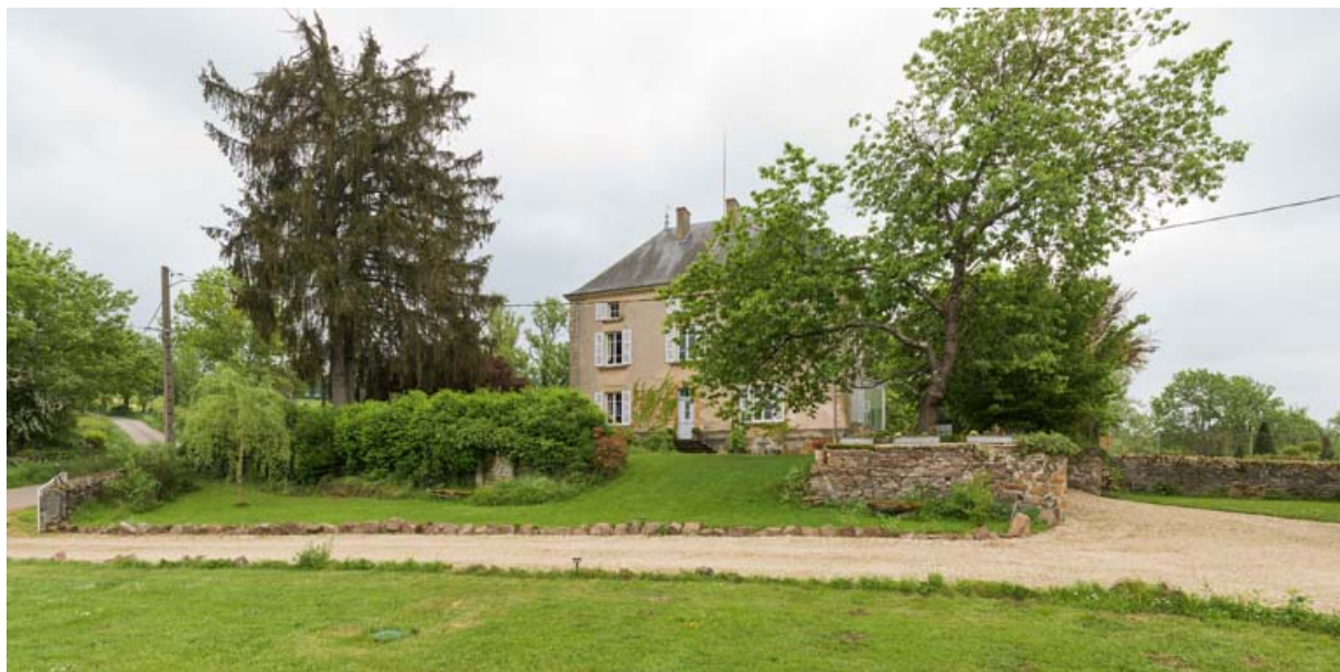
Maison d'habitation. Vue d'ensemble depuis le nord.
