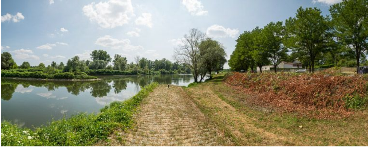
Le reste de bajoyer à la sortie du canal dans la Loire, à gauche.
