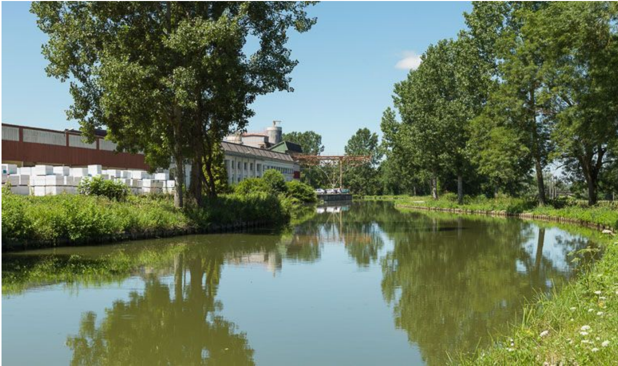
Vue d'ensemble de l'usine, rive gauche.
