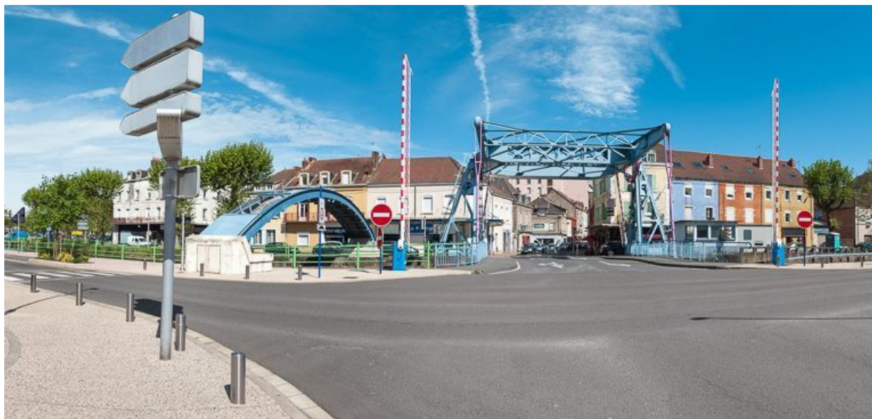
Vue d'ensemble du pont.
