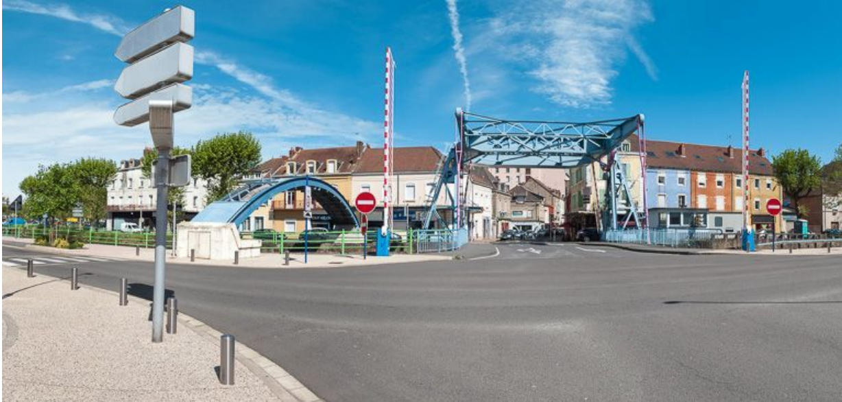
Vue d'ensemble du pont.
