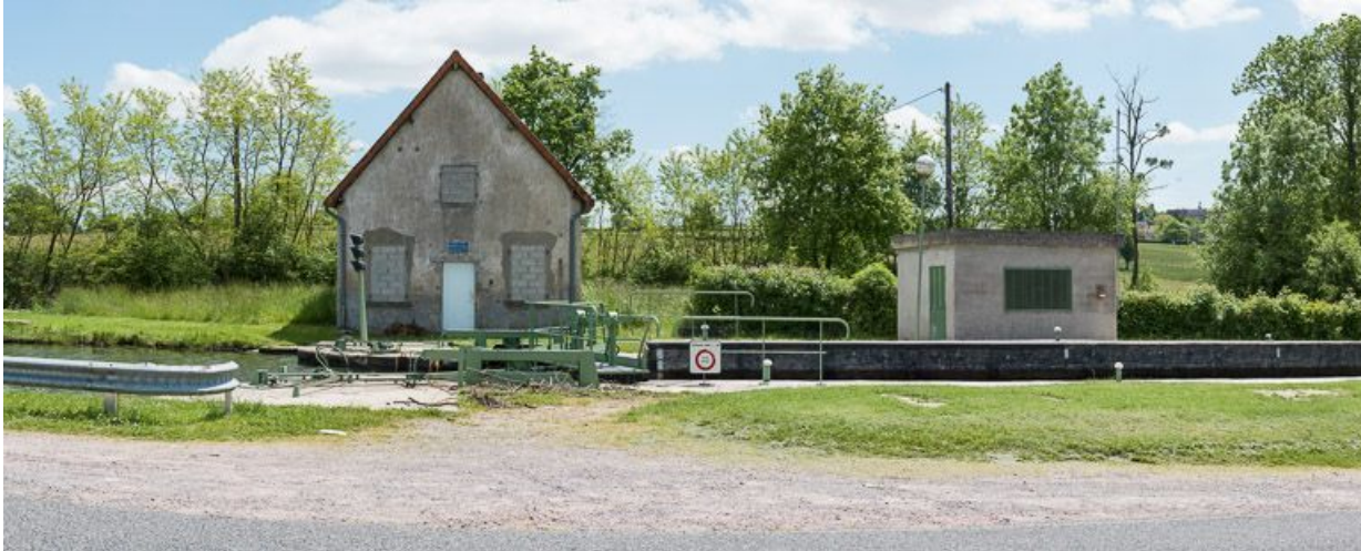
Vue de face de la maison éclusière.
