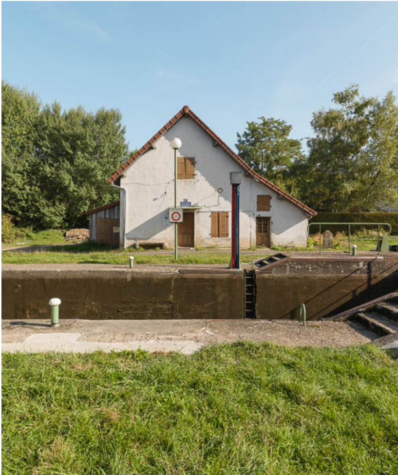
Vue de la maison éclusière.
