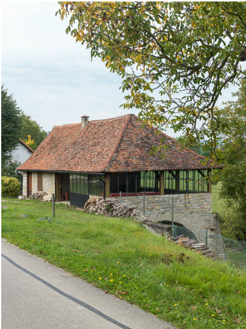
Vue du bâtiment situé en aval.
