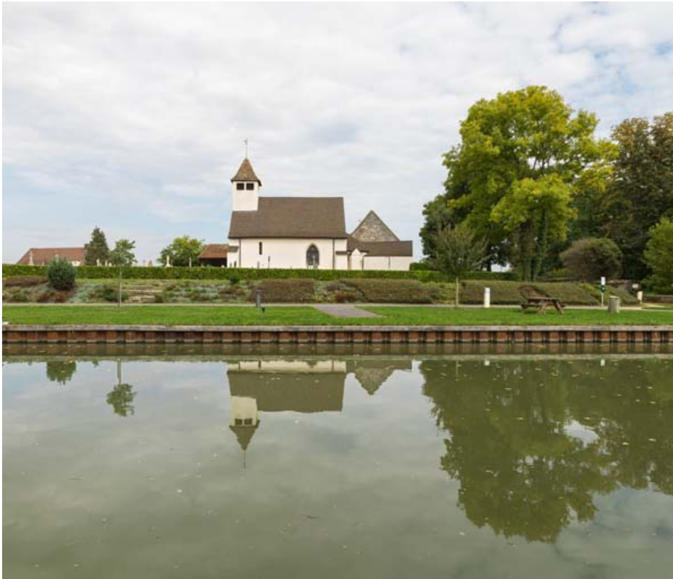
Vue de l'église le long du canal.
