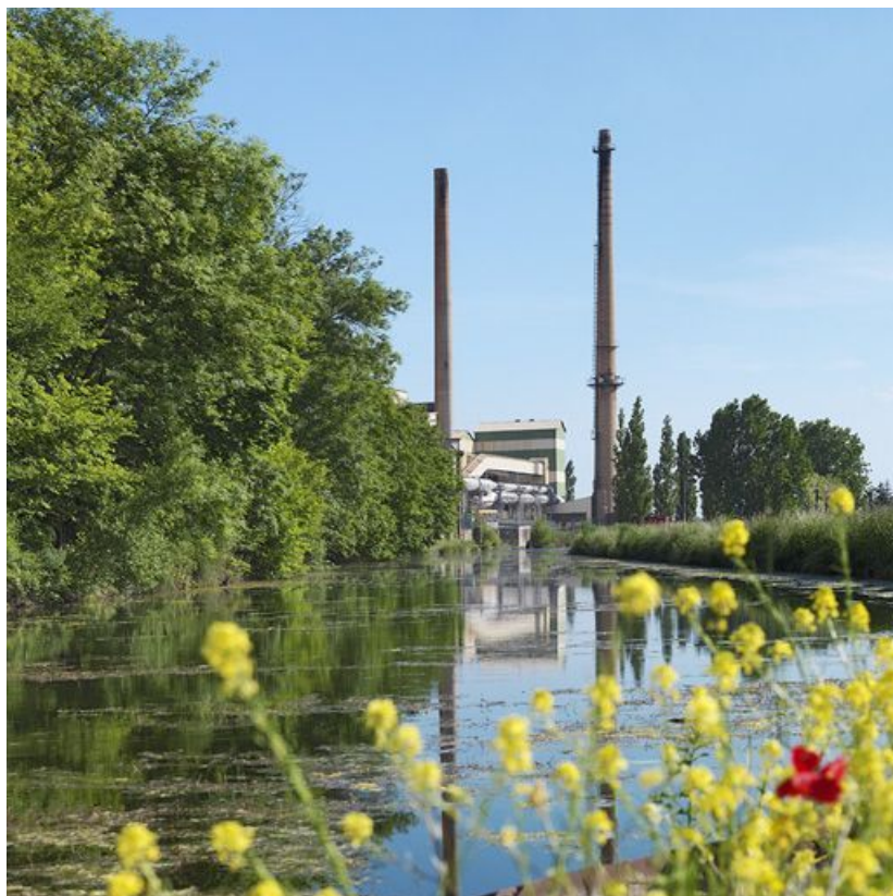
Vue générale de l'usine depuis l'embranchement.
