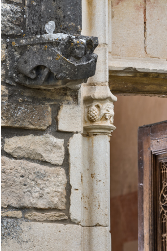
Piédroit, détail de la partie supérieure, gauche.
