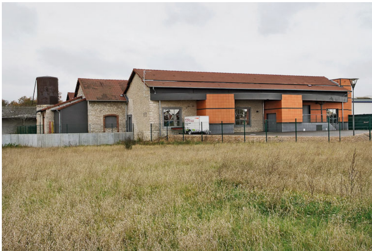
Vue d'ensemble du bâtiment.
