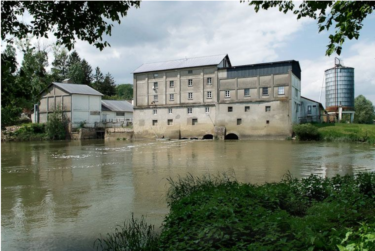
Le moulin : vue d'ensemble d'aval.
