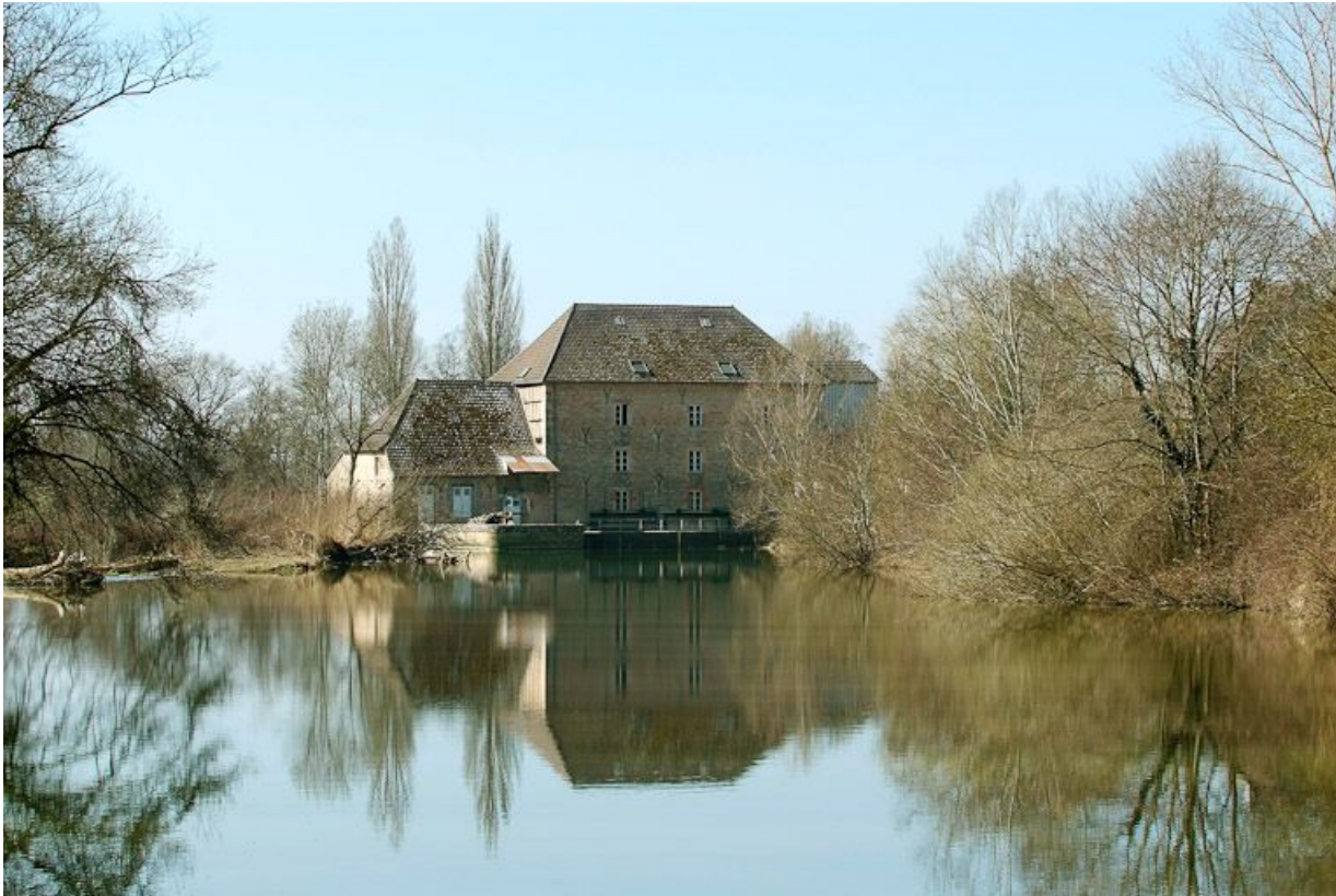
Moulin de Loisy, vu d'amont.
