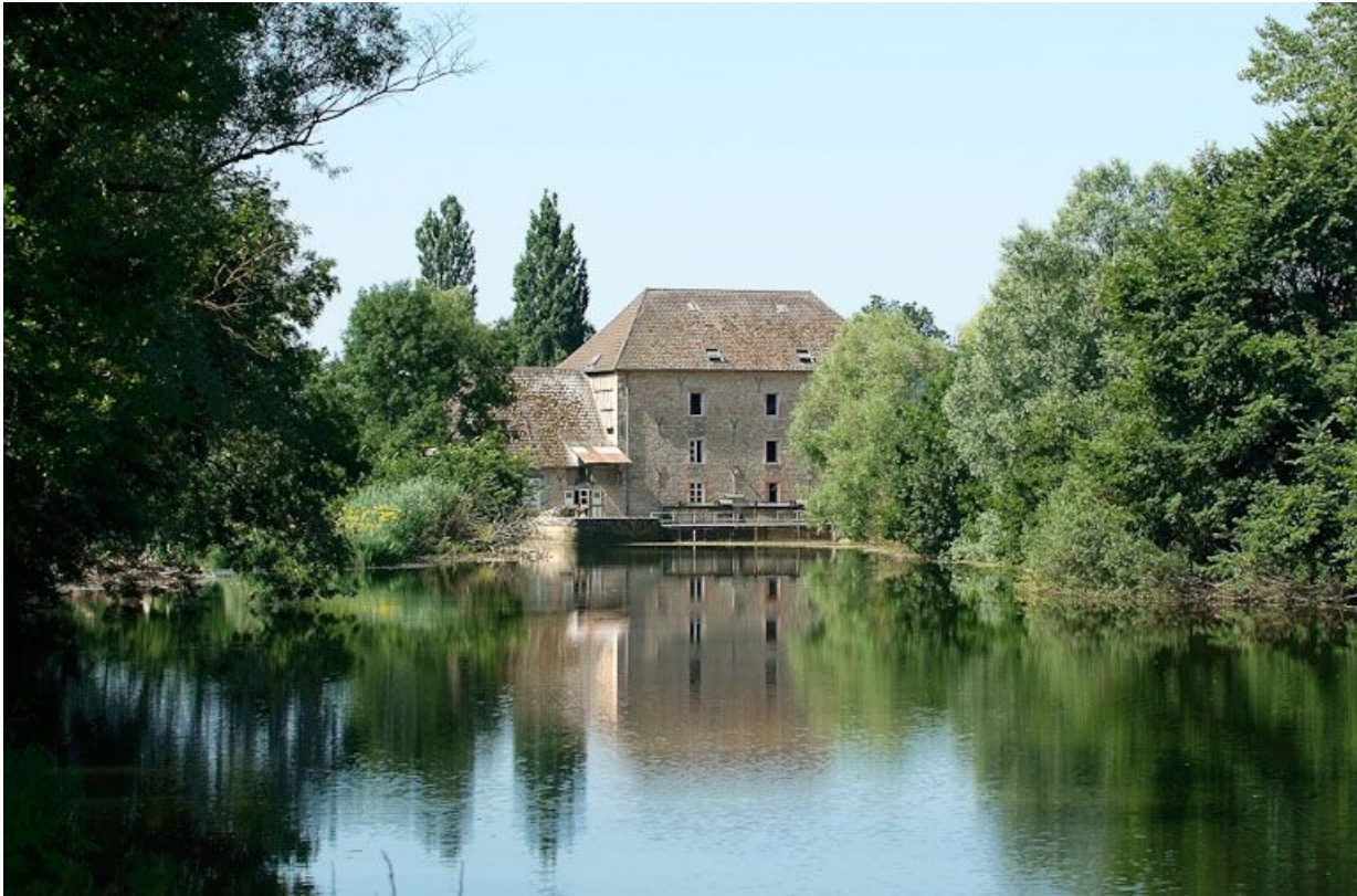
Moulin de Loisy, vu d'amont.
