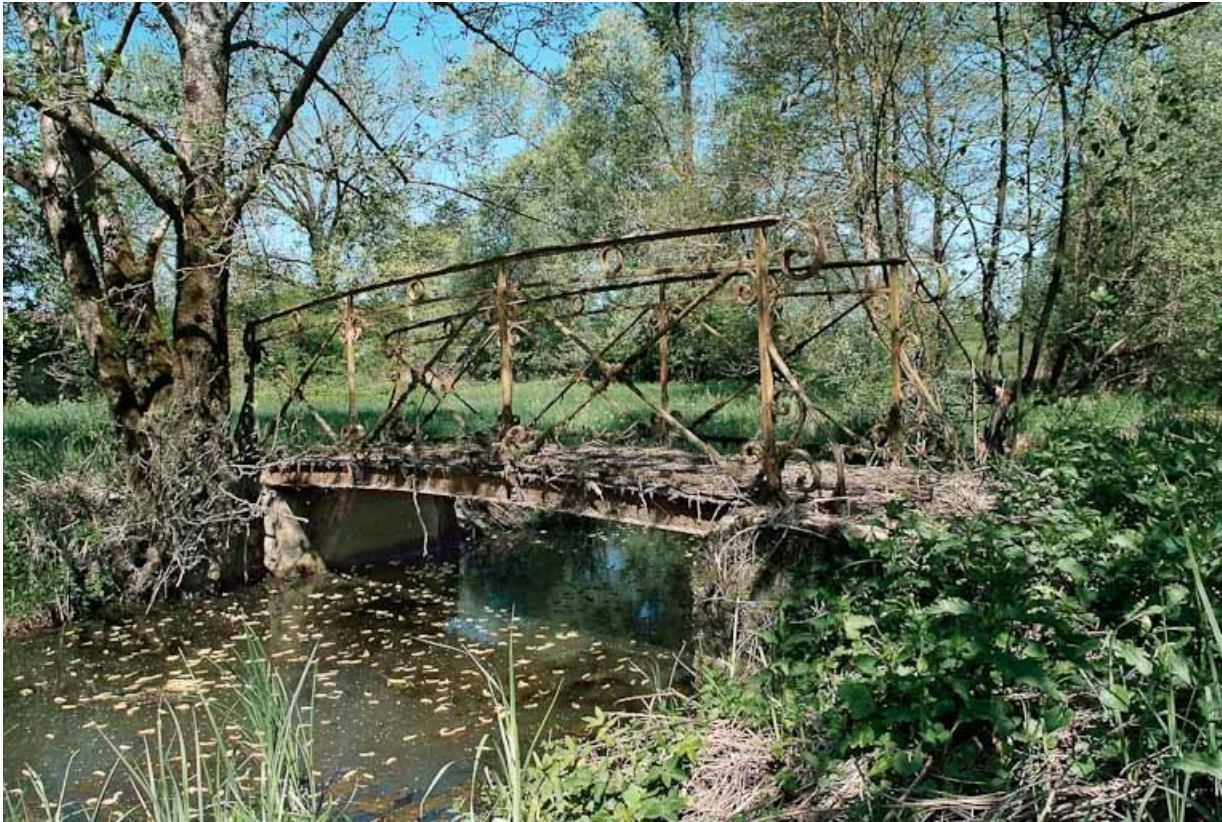
Passerelle métallique sur le Bief Michaud.
