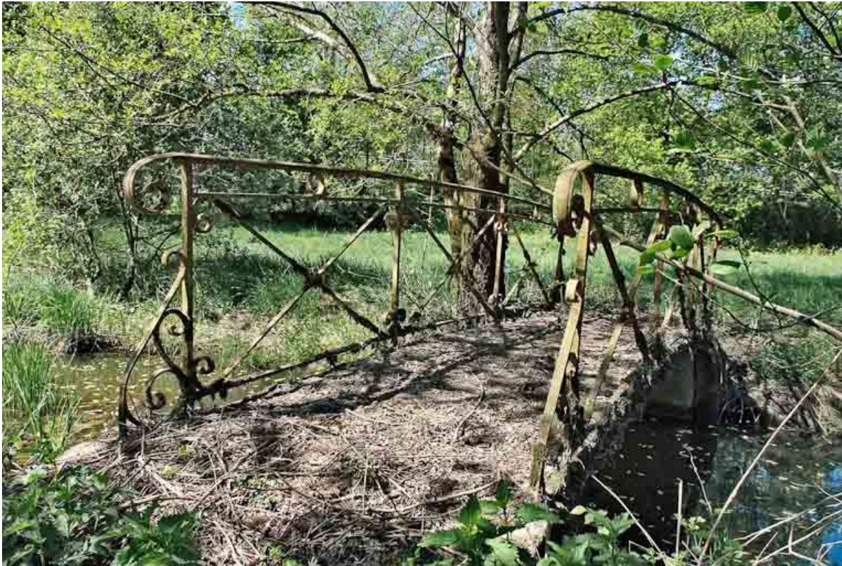
Passerelle métallique sur le Bief Michaud.
