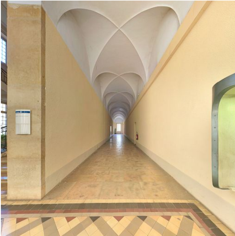
Couloir sud-est du rez-de-chaussée.
