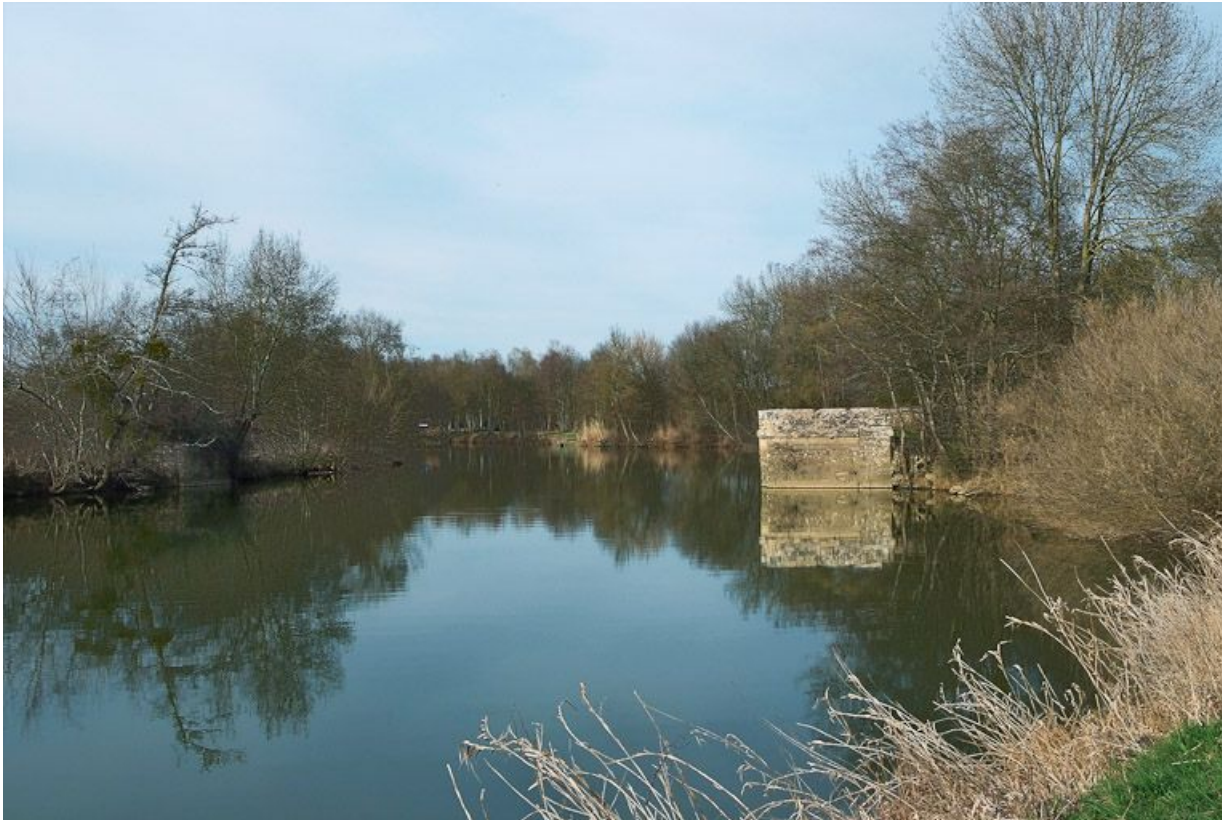
Pile de l'ancien pont à bascule.
