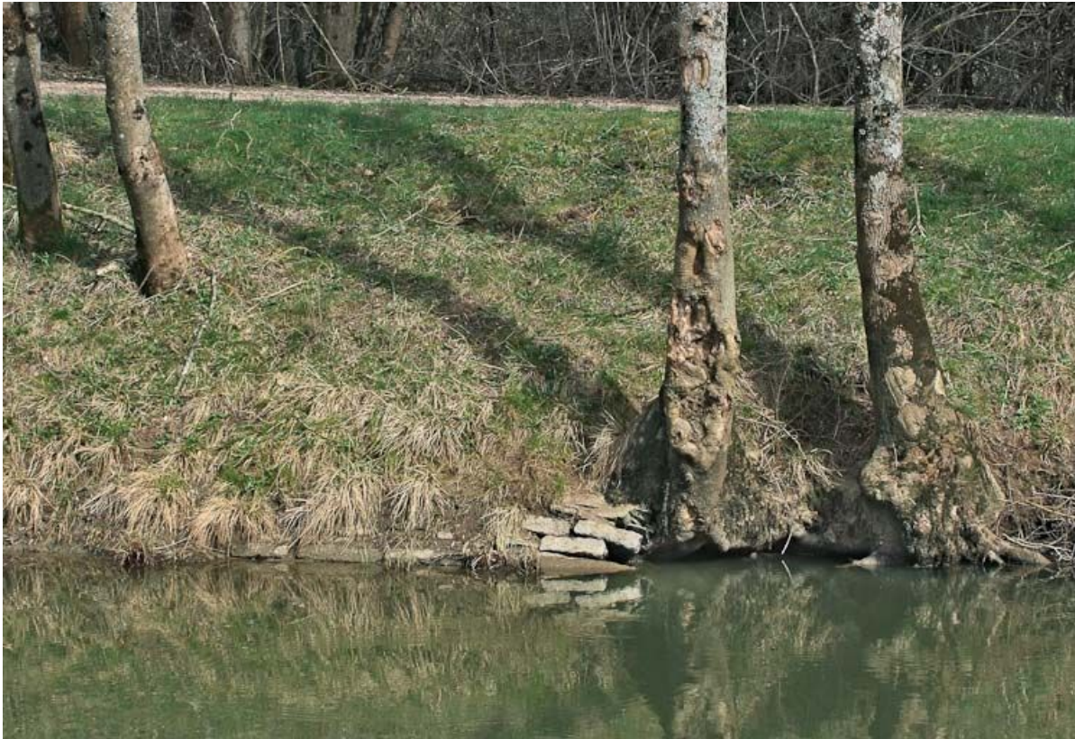
Emplacement de l'aqueduc du Pont à Bascule, désordres dans le perré.
