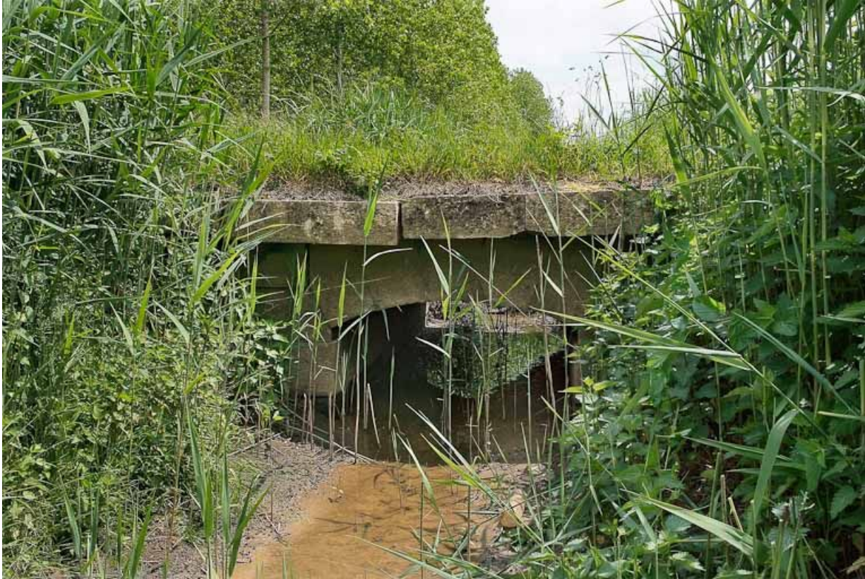
Ponceau, vue rapprochée.
