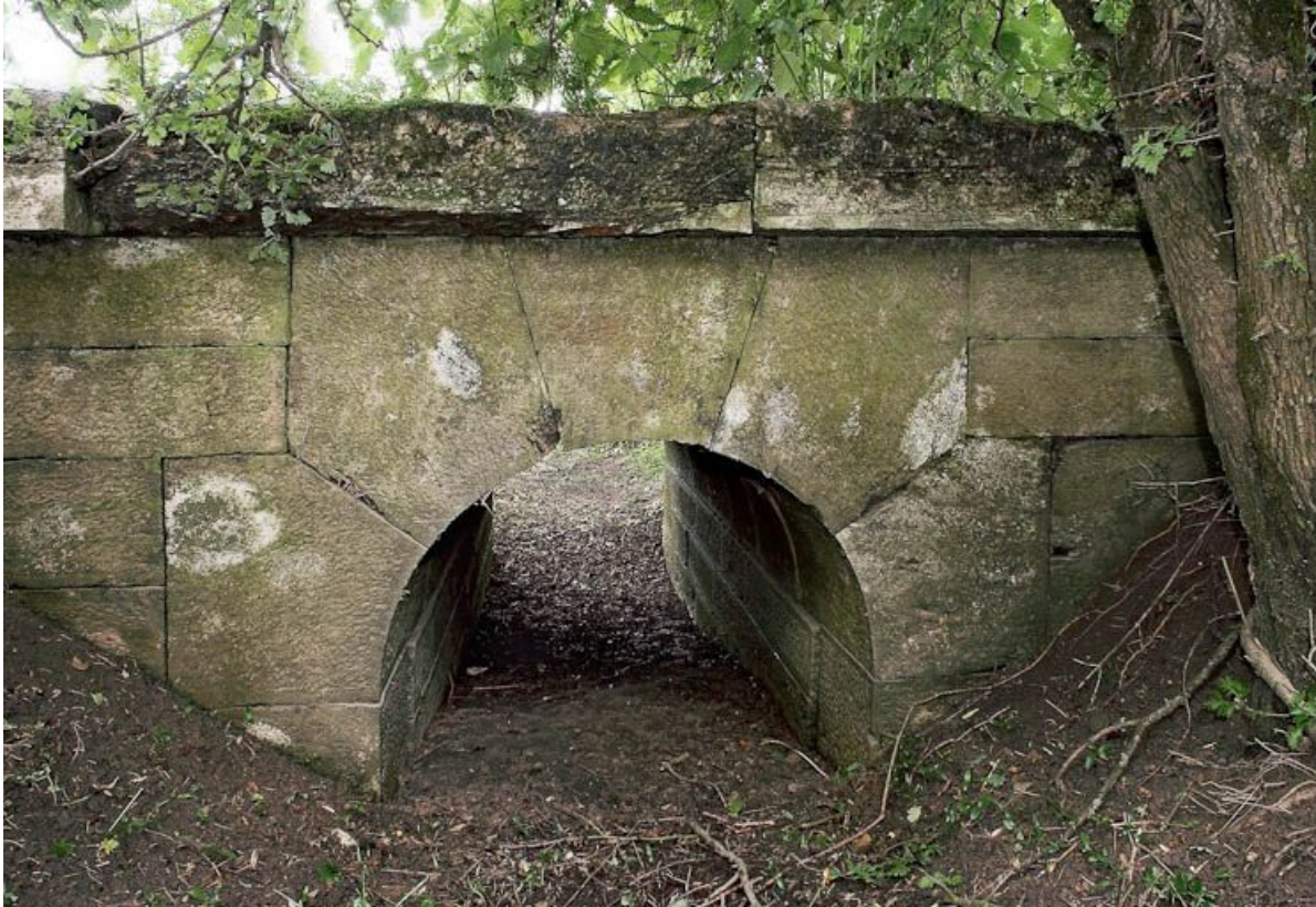
Ponceau, vue rapprochée.
