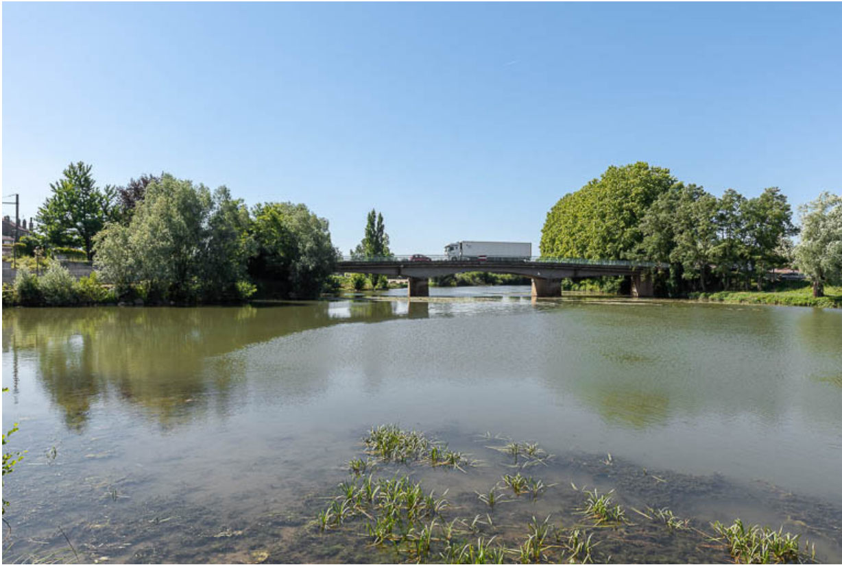
Vue générale du pont et du site.
