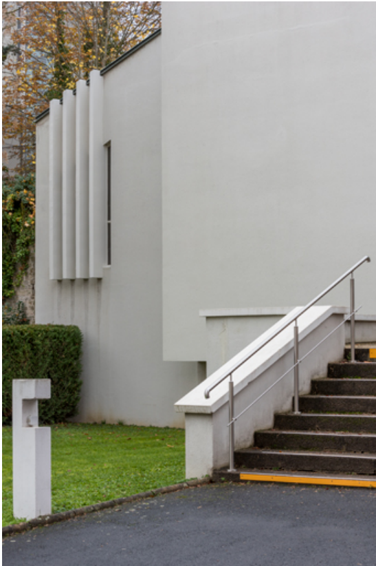
Détail de la façade est.
