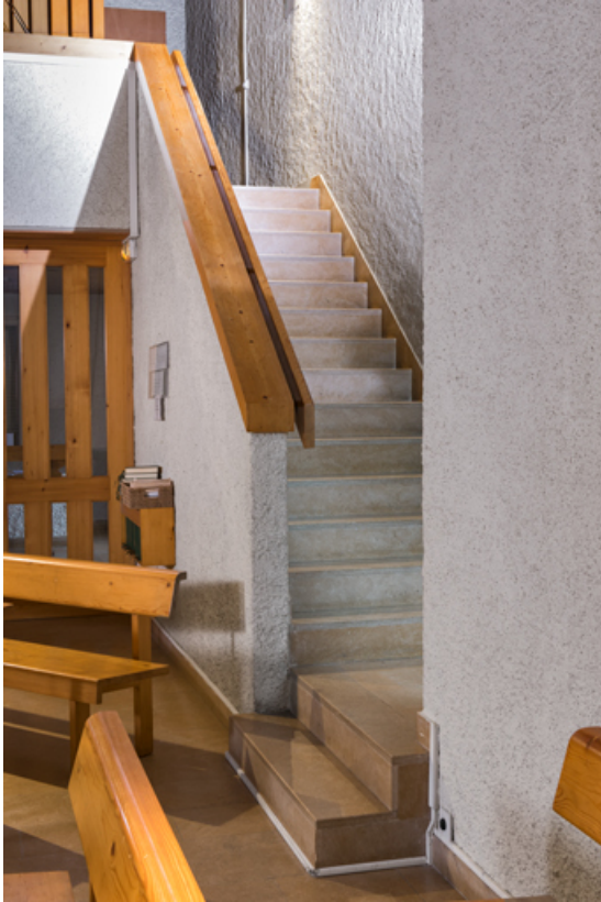
Vue de l'escalier de la tribune.
