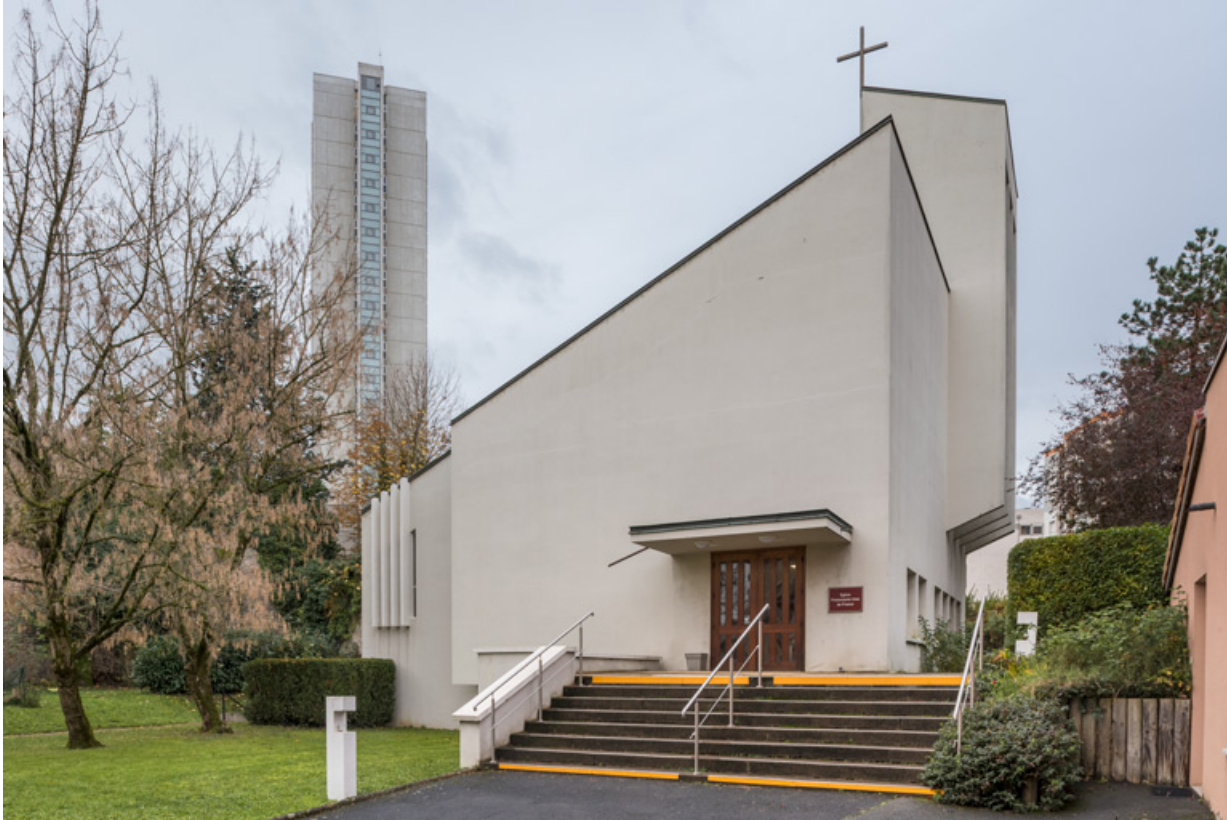
Vue de la façade est.
