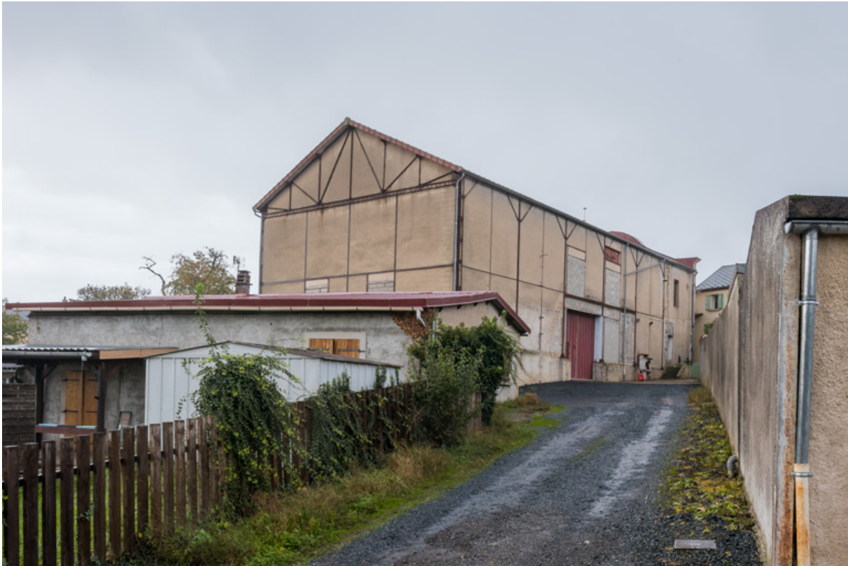
Façades postérieure et latérale gauche.
