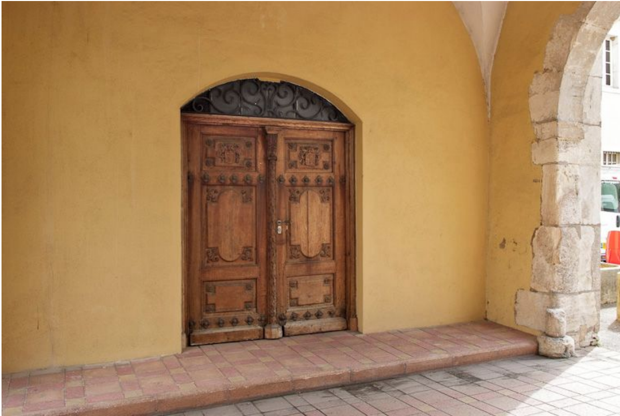
Porte d'accès au couloir des cuisines et au réfectoire.
