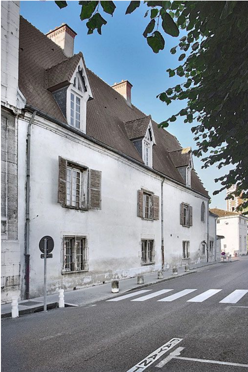
Corps de logis du 16e siècle : façade sur la Saône. 71, Chalon-sur-Saône Hôpital
