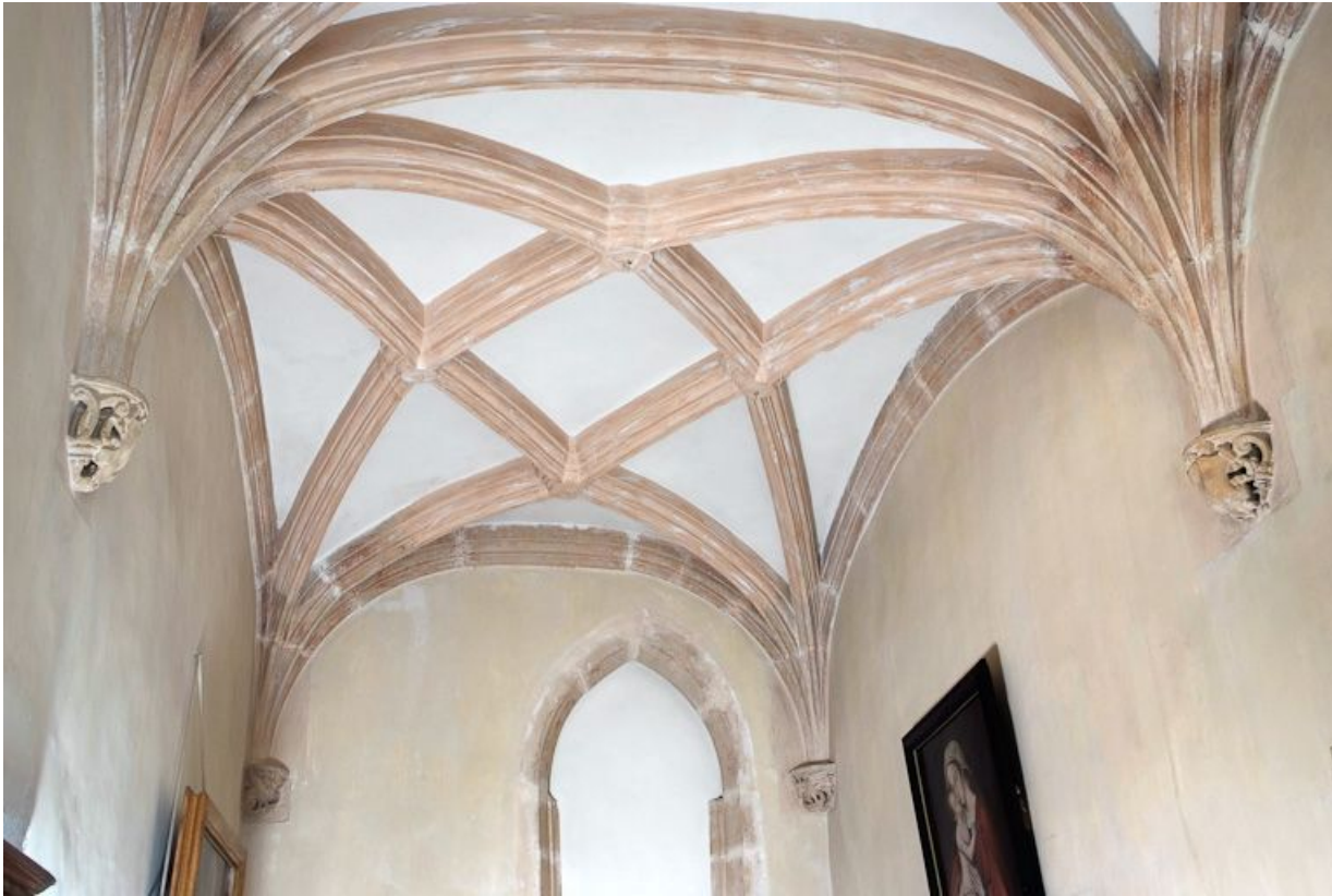
Voûte de l'oratoire.
