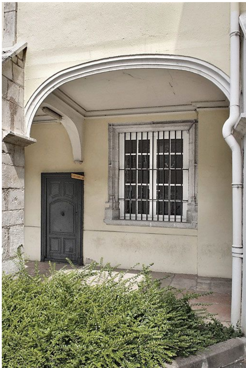
Fenêtre du corps de logis du 16e siècle.
