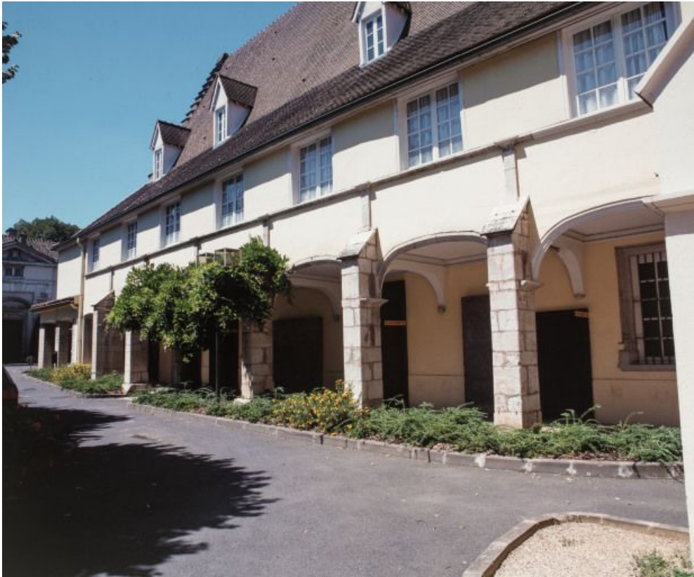
Corps de logis du 16e siècle : façade sur cour.
