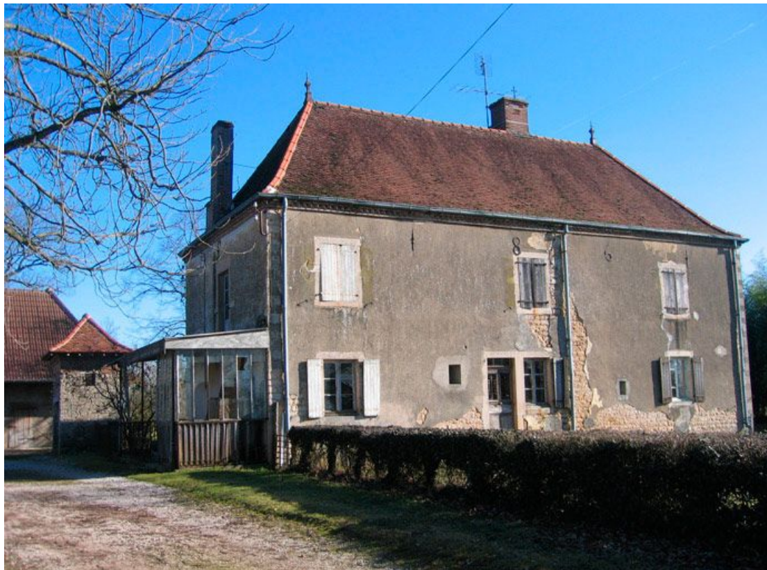
Vue d'ensemble de la façade.
