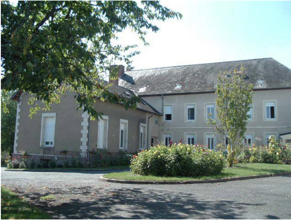
Vue d'ensemble de la façade postérieure.
