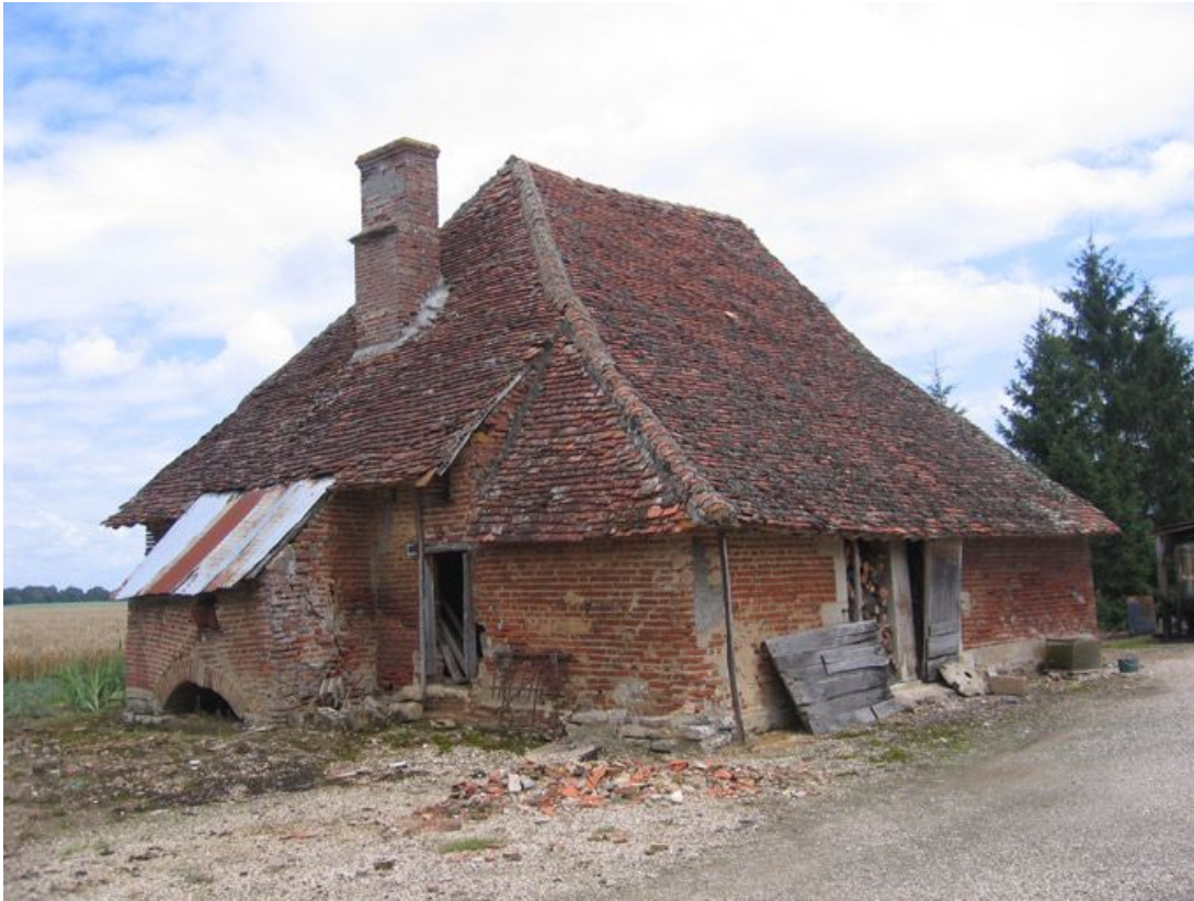
Vue d'ensemble de la façade postérieure.
