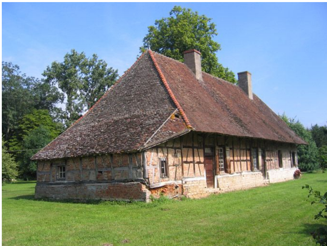
Vue d'ensemble de la façade.
