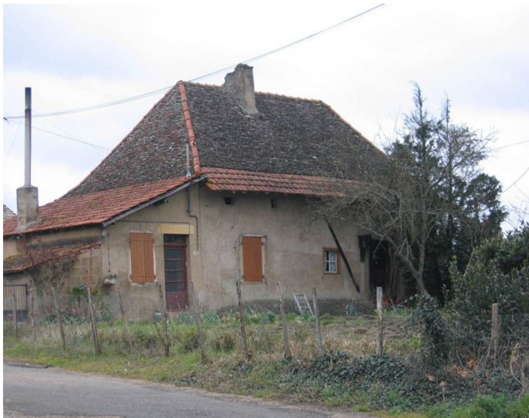
Vue d'ensemble de la façade.
