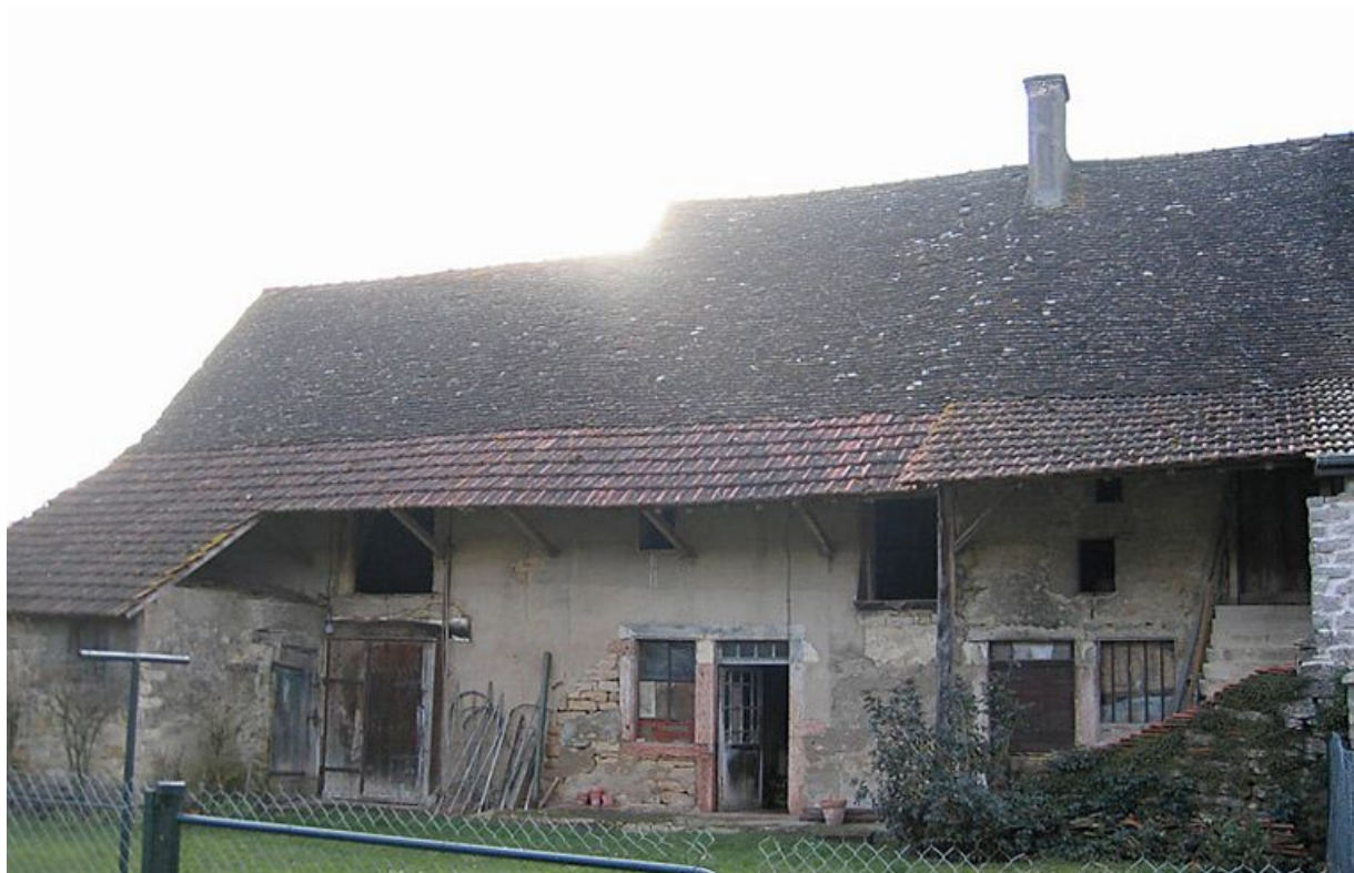
Vue d'ensemble de la façade.
