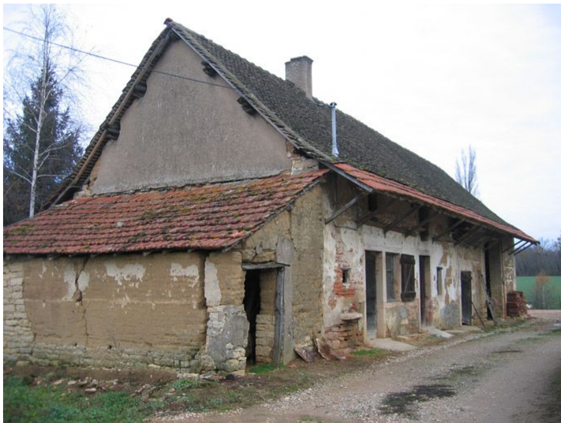
Vue d'ensemble de la façade.
