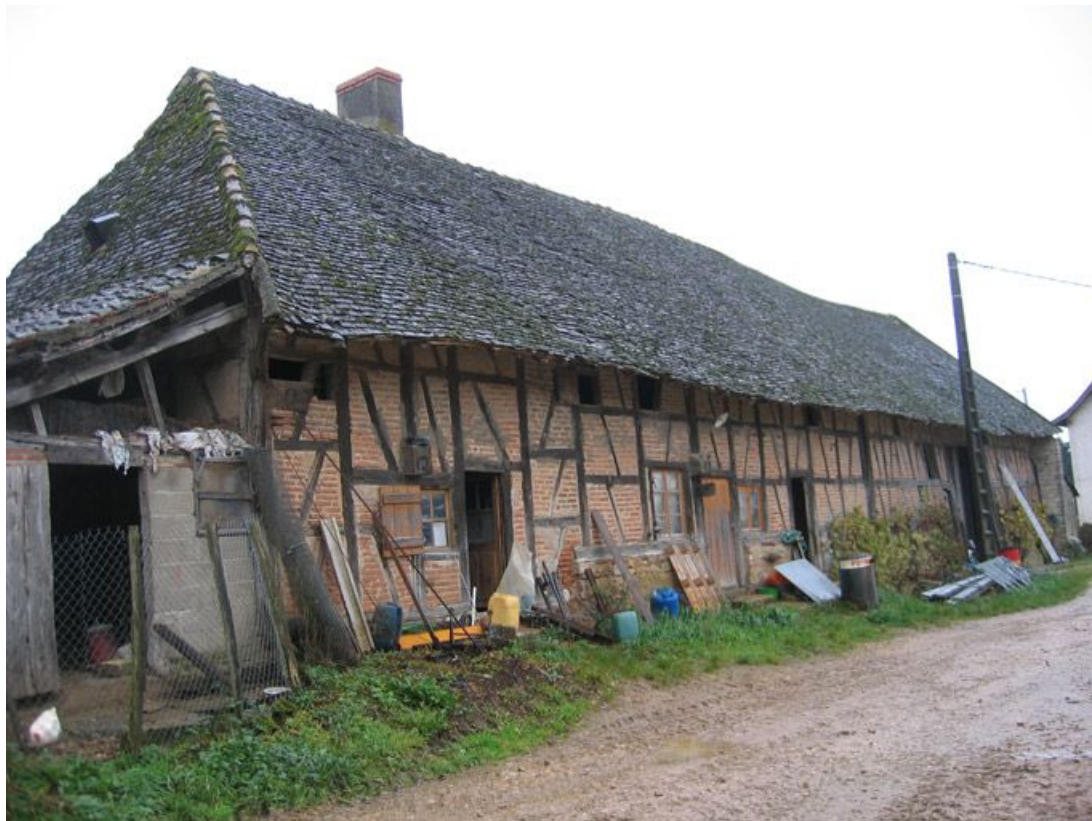
Vue d'ensemble de la façade.
