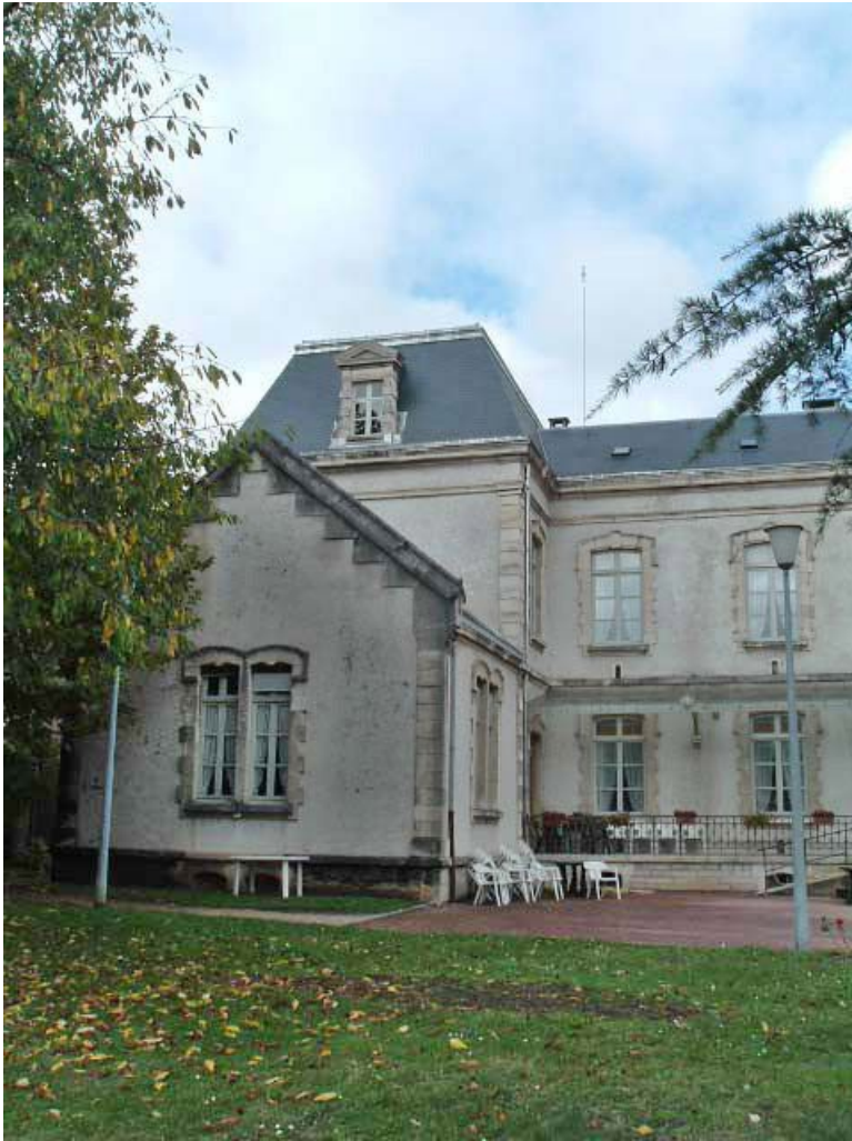
Vue partielle de l'aile gauche.
