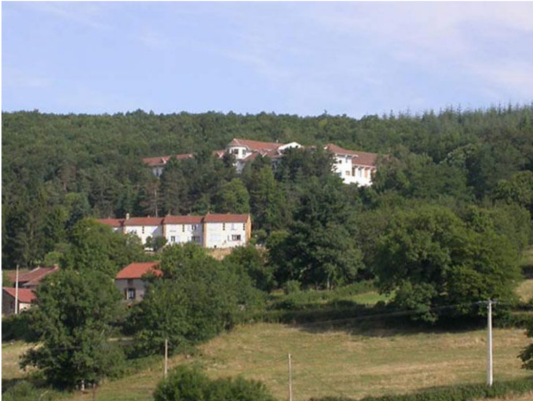
Vue générale du bâtiment dans la forêt.
