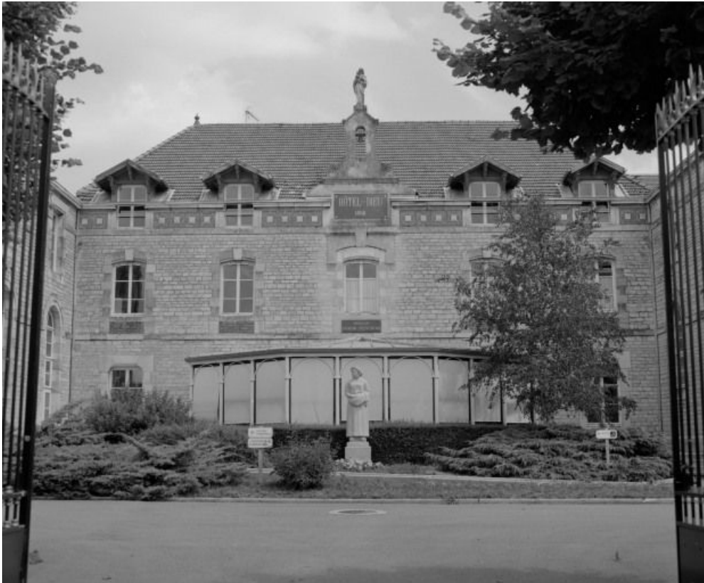
Façade antérieure, partie centrale.
