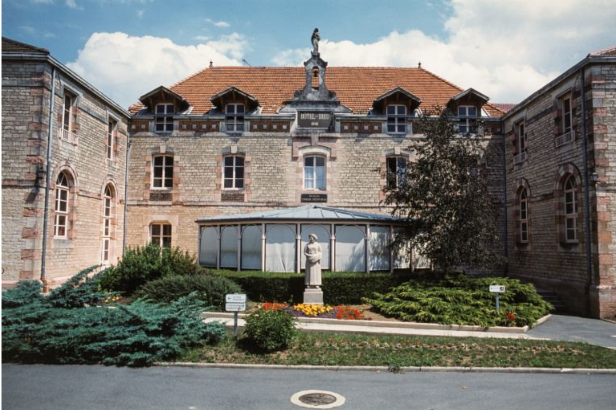
Façade antérieure, partie centrale
